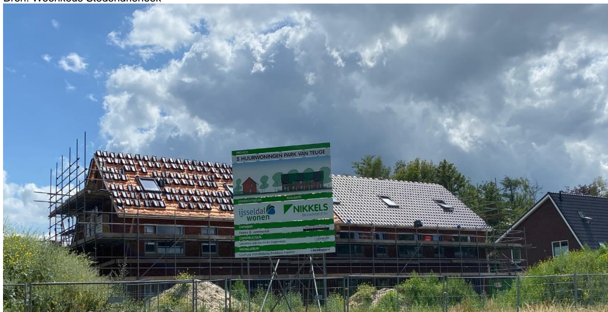
Park van Teuge in aanbouw
